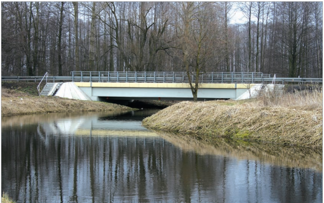
Fot. 21. Przejście dolne dla małych zwierząt zespolone z cieką – niski most nad rzeką obejmujący strefy brzegowe powyżej poziomu wody – droga krajowa nr 7.
