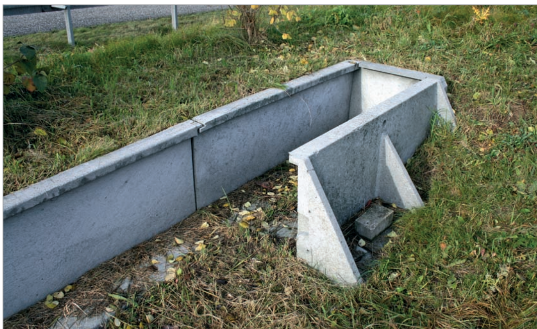
Fot. 130. Zakończenie ogrodzenia dla płazów wykonanego z prefabrykatów polimerobetonowych.
