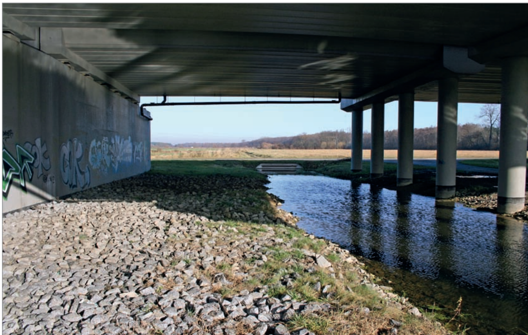
Fot. 118. Suche półki pokryte niewłaściwym materiałem – grube kruszywo łamane (granit) – utrudnienia dla przemieszczania ssaków kopytnych.
