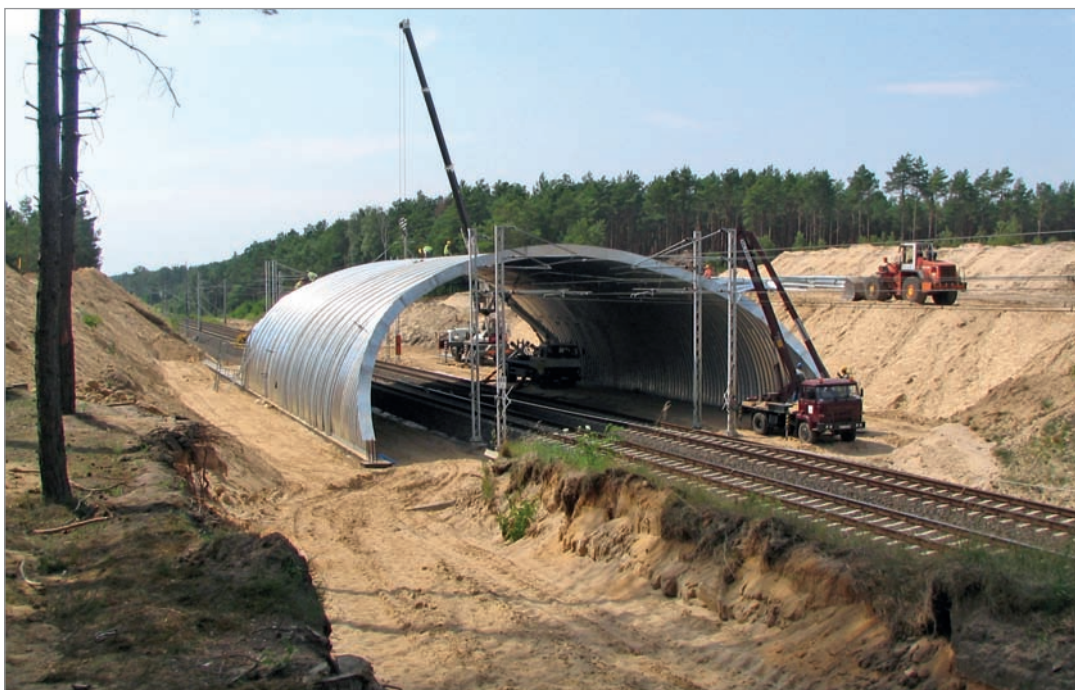
Fot. 166. Odpowiednie wkomponowanie w otoczenie przejść górnych przy linii E2o wymagało m.in. korekty rozstawu słupów trakcyjnych, korekty odwodnienia podtorza i przebudowy linii LPN.
