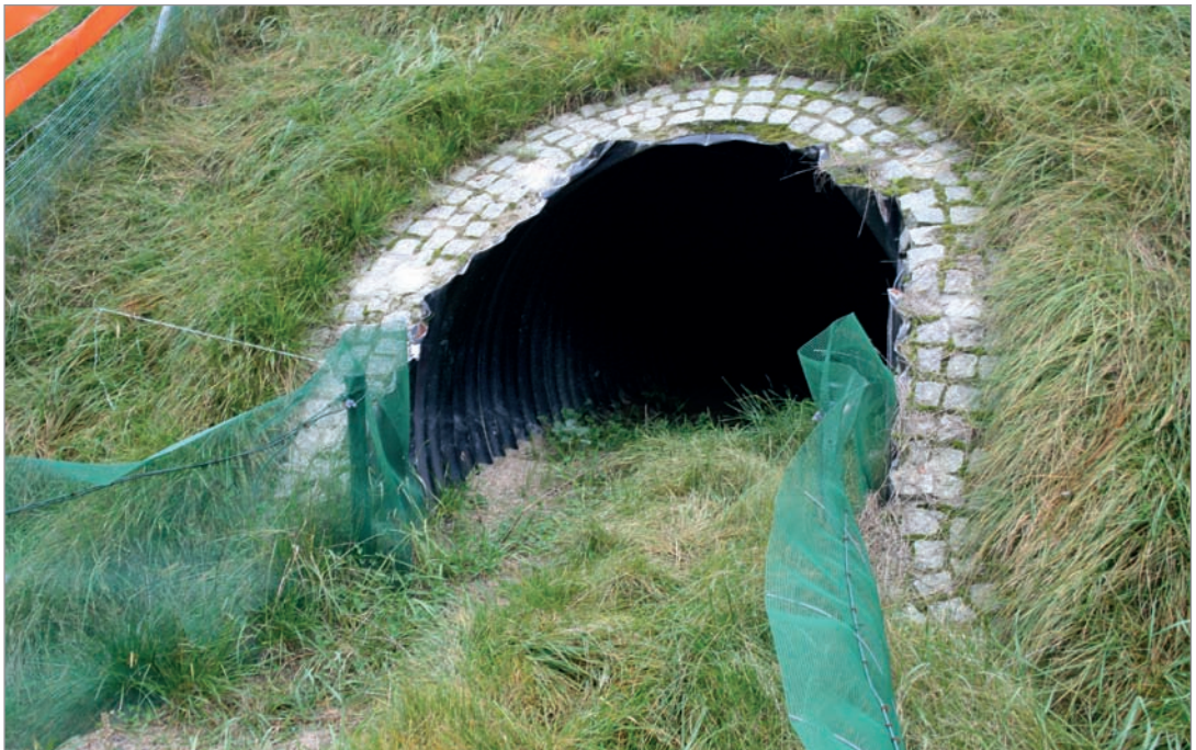
Fot. 50. Przejście dla małych zwierząt – przepust z blachy falistej – autostrada A4.
