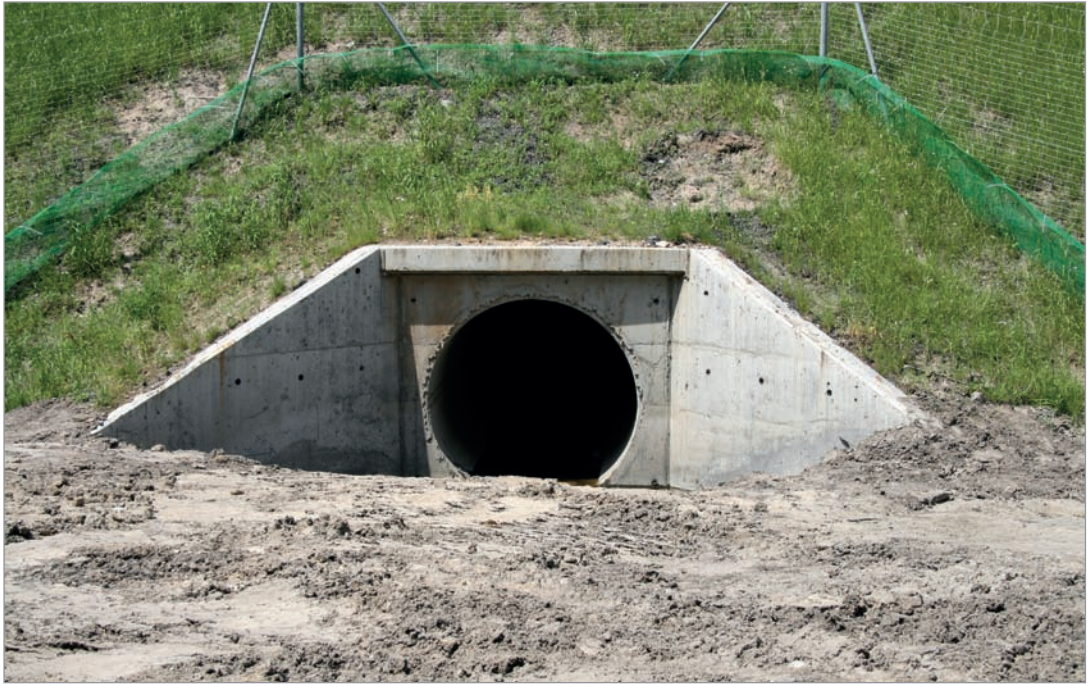
Fot. 49. Przejście dla małych zwierząt – przepust żelbetowy ze skrzydłami ukośnymi – autostrada A1.
