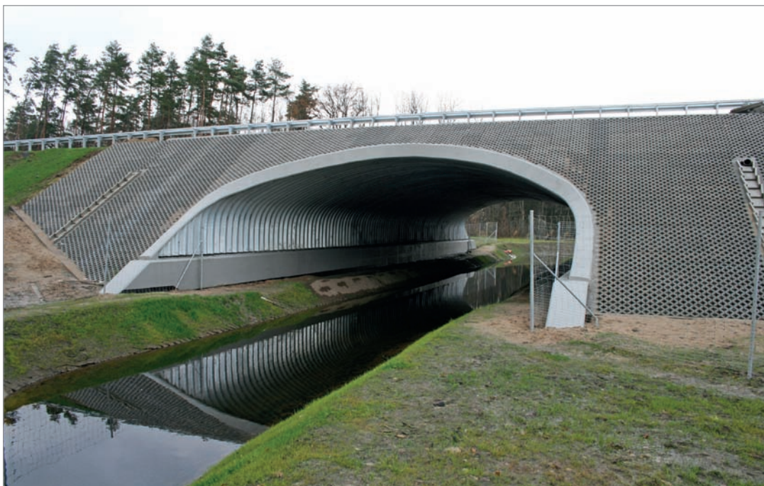
Fot. 44. Przejście dolne dla średnich zwierząt zespolone ze strumieniem – konstrukcja z blachy falistej na ławach żelbetowych – droga ekspresowa S-3.
