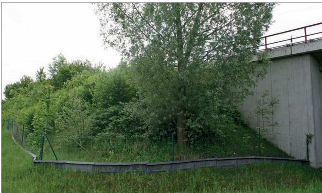
Fot. 63. Skarpy wokół przyczółków przejść dolnych powinny być pokryte gruntem i obsadzone roślinnością osłonowo-izolacyjną.
