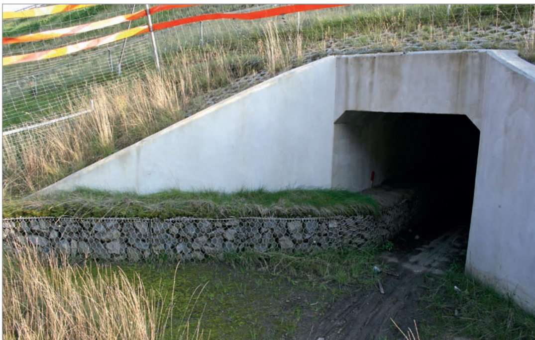
Fot. 59. Półka gabionowa pokryta szczelnie gruntem i darnią.
