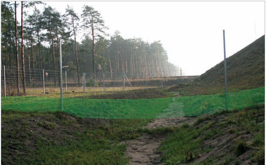
Fot. 133. Przekraczanie otwartych rowów zawsze powoduje nieszczelności ogrodzenia przy dolnej krawędzi.
