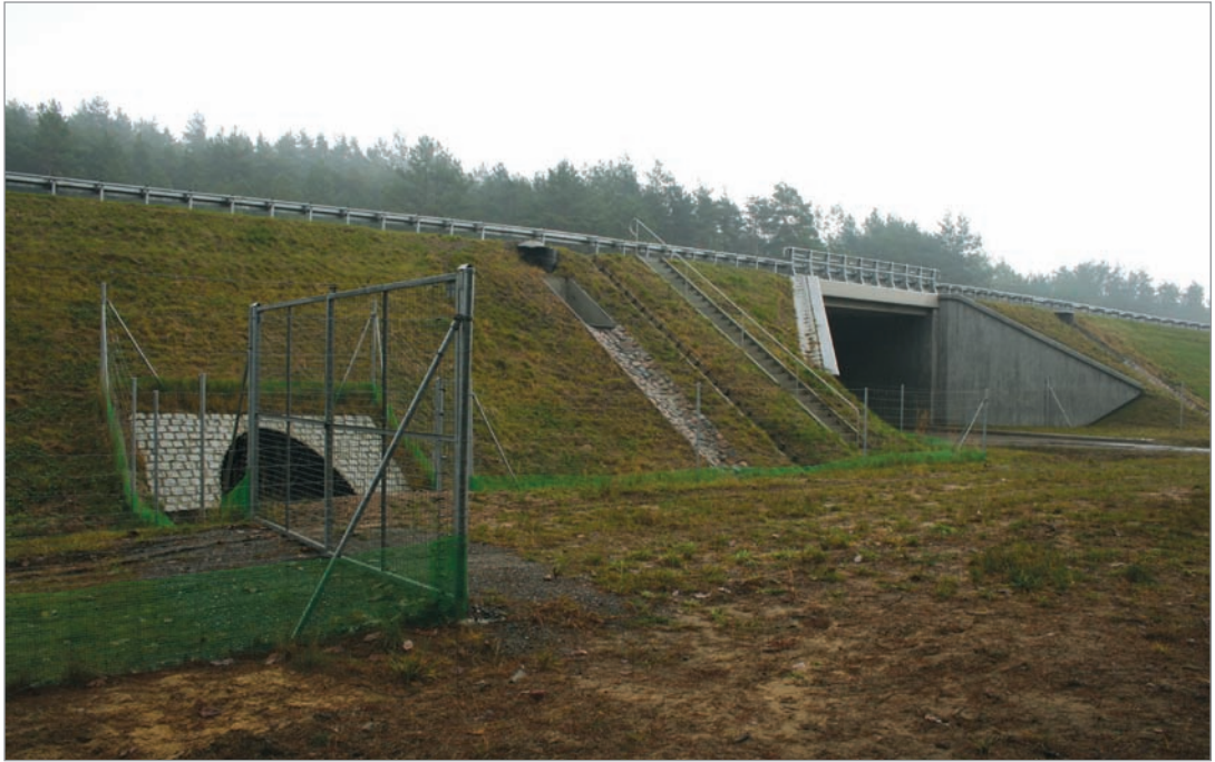
Fot. 5. Przejście dla małych zwierząt (przeput) zlokalizowane w bezpośrednim sąsiedztwie przejścia dolnego (zespolonego) dla średnich zwierząt – autostrada A1.
