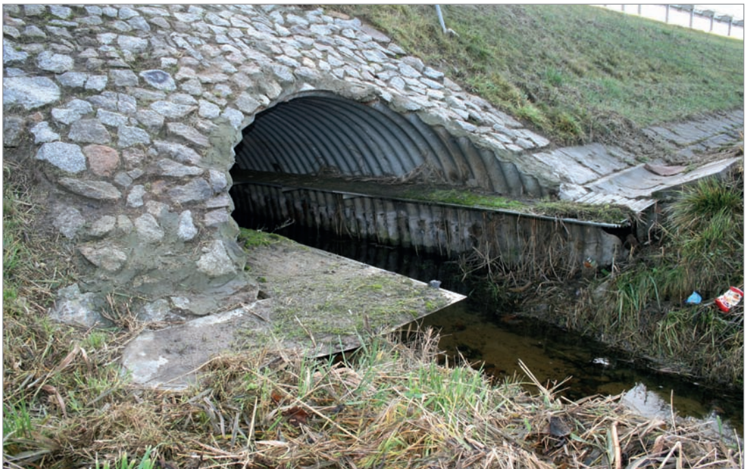
Fot. 58. Półki podwieszane pokryte gruntem w przepuście stalowym.
