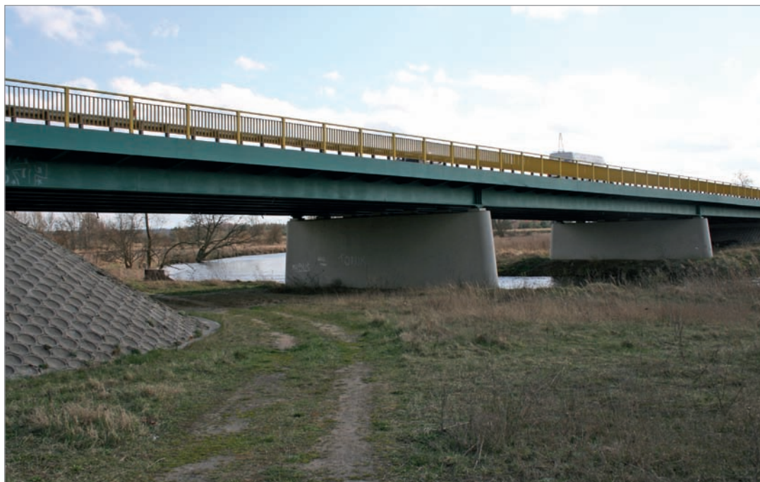
Fot. 80. Podpory o konstrukcji ograniczającej dostęp światła do powierzchni przejścia – droga krajowa nr 11.
