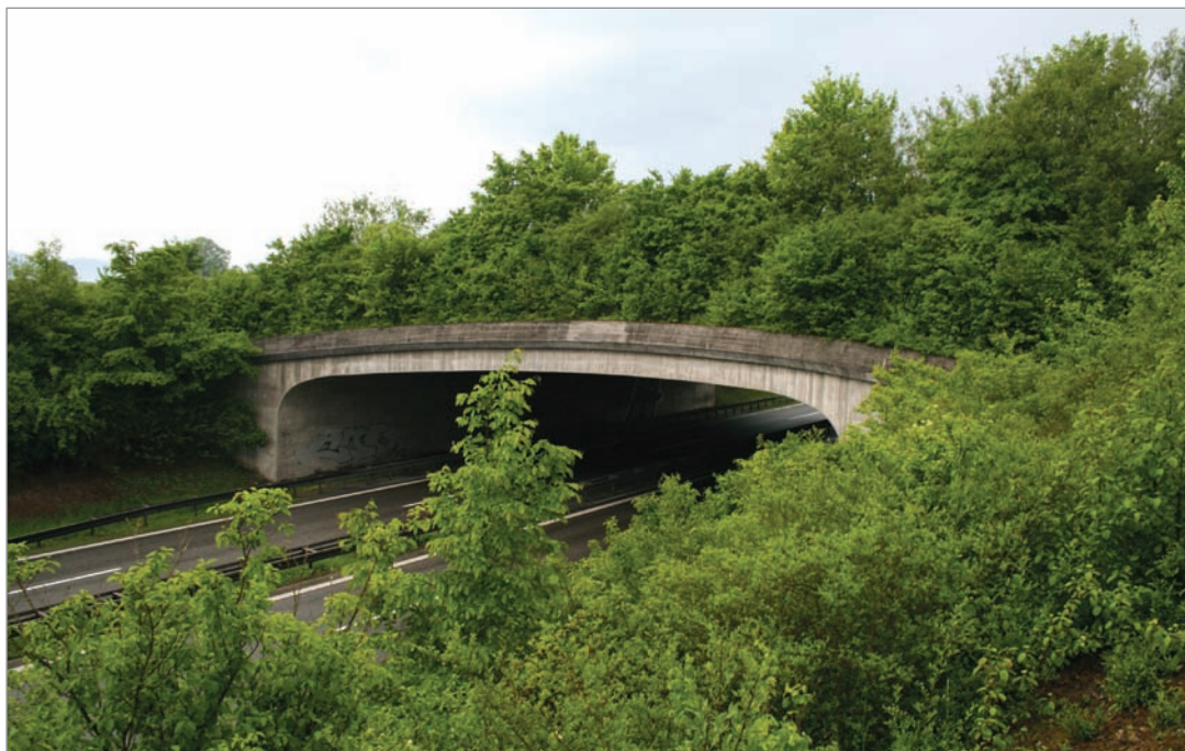
Fot. 23. Przejście górne optymalnie zagospodarowane i połączone z otoczeniem – droga ekspresowa B33 (Niemcy).
