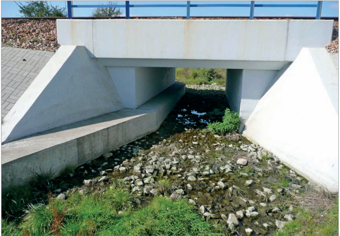
Fot. 163. Przejście dolne zespolone (z półką podwieszaną) dla małych zwierząt przy linii kolejowej Warszawa–Łódź.
