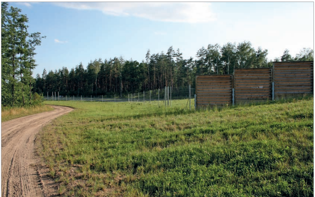
Fot. 69. Przejście górne z drogą serwisową u podstawy najść – autostrada A4.
