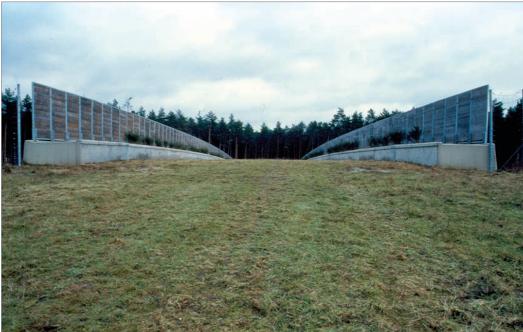
Fot. 73. Wąskie przejście górne niedostosowane do wymagań dużych i średnich ssaków – autostrada A4.
