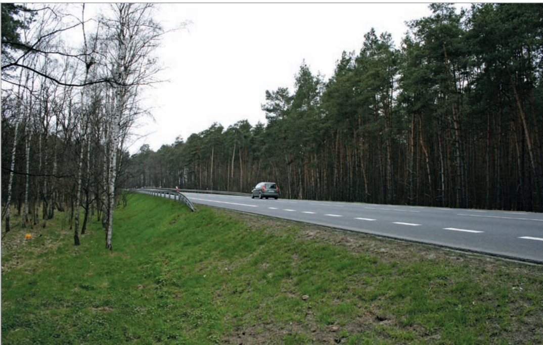
Fot. 10. Przykład przejścia po powierzchni drogi wykorzystywanego przez ssaki kopytne – droga krajowa nr 2.
