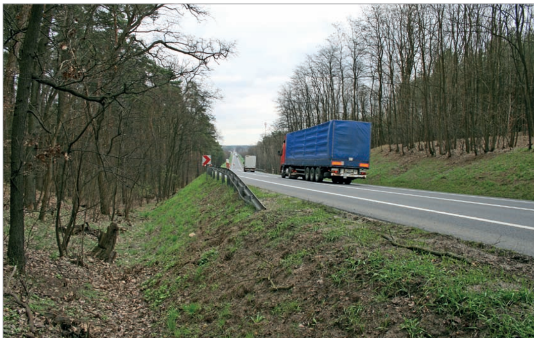
Fot. 72. Wysokie nasypy utrudniają funkcjonowanie przejść po powierzchni drogi, zwierzęta szukając najdogodniejszych miejsc, zwykle przechodzą bezpośrednio przy zakończeniach barier ochronnych – droga krajowa nr 2.
