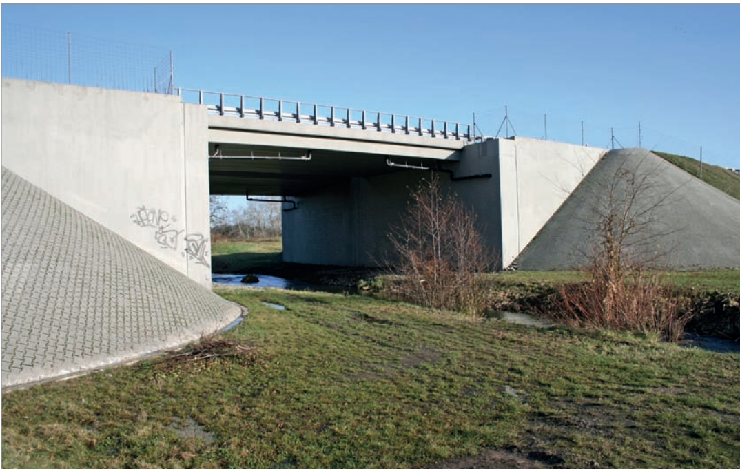
Fot. 77. Przejście posiadające duże, widoczne powierzchnie betonowe – trudne do wkomponowania w otoczenie i odstrasające niektóre zwierzęta – autostrada A2.
