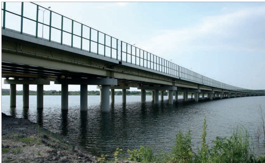
Fot. 142. Ekran transparentny na przejściu dolnym.
