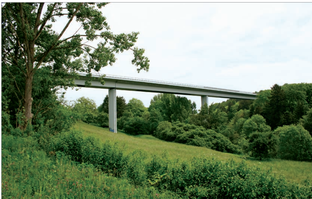
Fot. 9. Estakada spełniająca funkcje mostu krajobrazowego – autostrada A98 (Niemcy).
