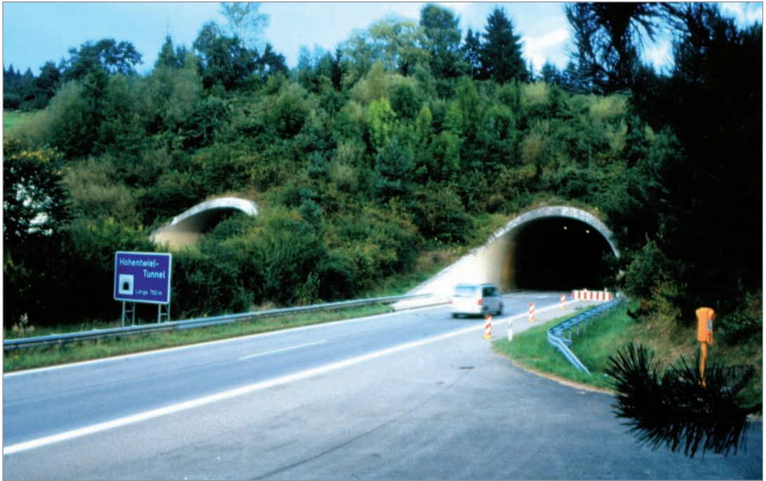
Fot. 8. Tunel drogowy Hohentwiel spełniający funkcję przejścia krajobrazowego – autostrada A81 (Niemcy).
