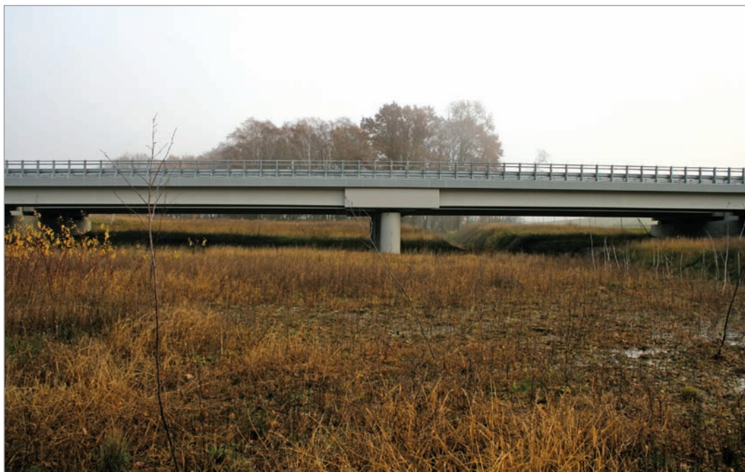
Fot. 19. Przejście dolne dla dużych zwierząt zespolone z drogą leśną – droga ekspresowa S-3.
