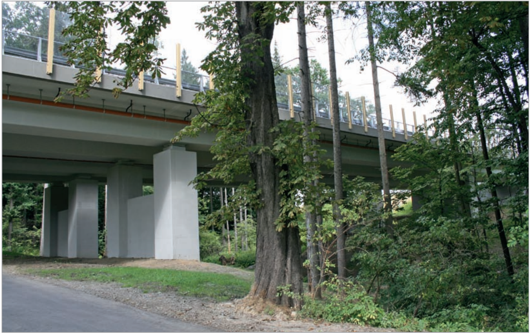
Fot. 81. Ekran transparentny na dolnym przejściu dla dużych zwierząt – Rezerwat Morzyk, droga ekspresowa S-1.
