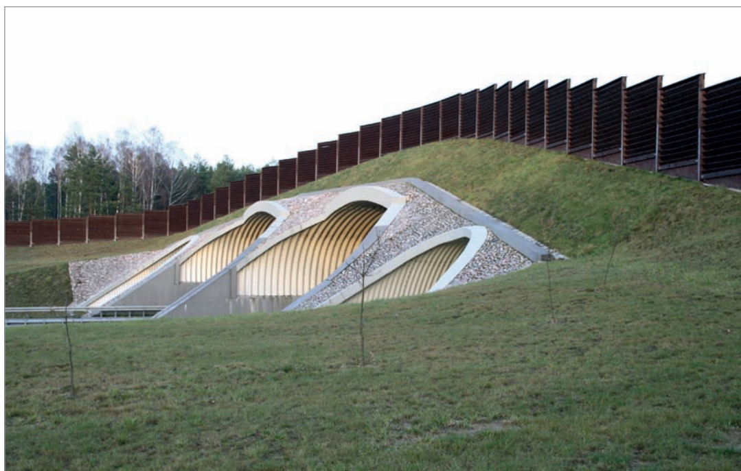
Fot. 70. Przejście górne na autostradą i równoległymi drogami serwisowymi – autostrada A2.
