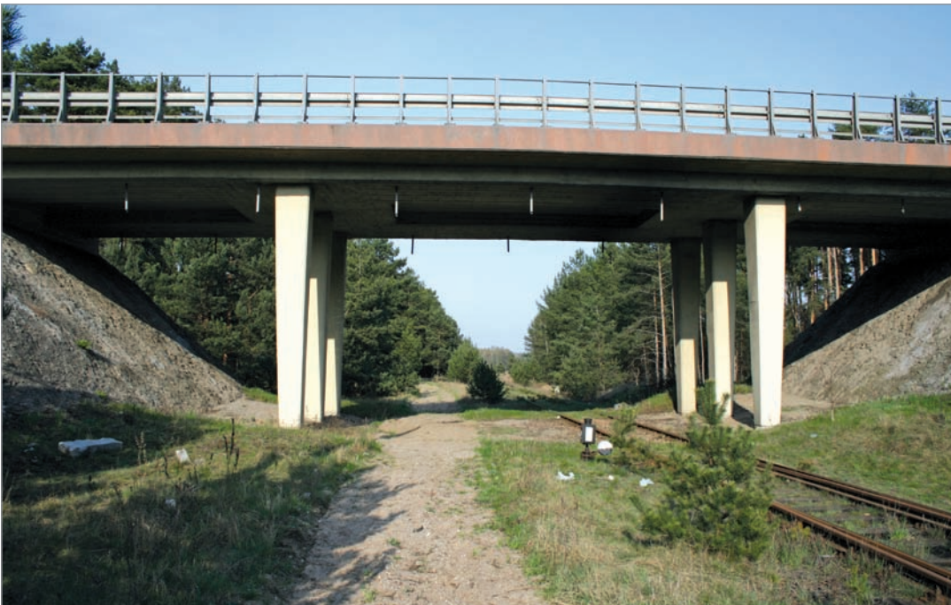
Fot. 20. Przejście dolne dla średnich zwierząt zespalone z linią kolejową – droga krajowa nr 10.
