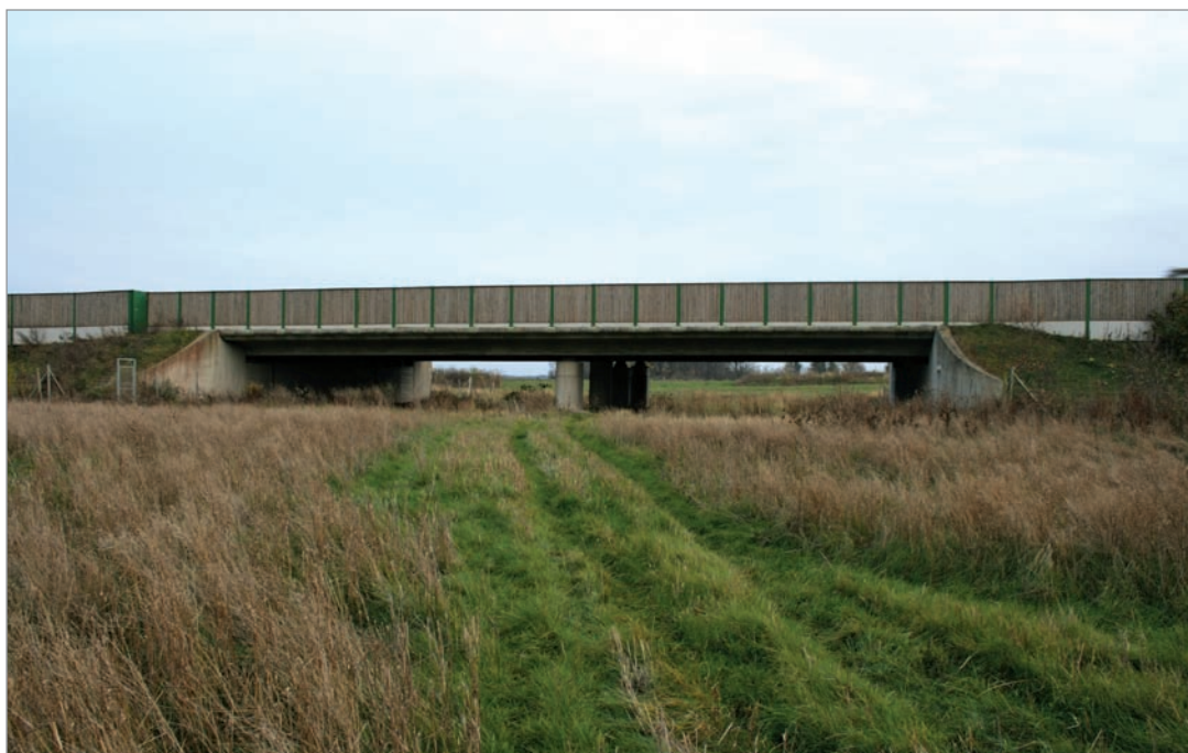
Fot. 39. Przejście dolne dla średnich zwierząt – konstrukcja żelbetowa, dwuprzęsłowa – autostrada A20 (Niemcy).
