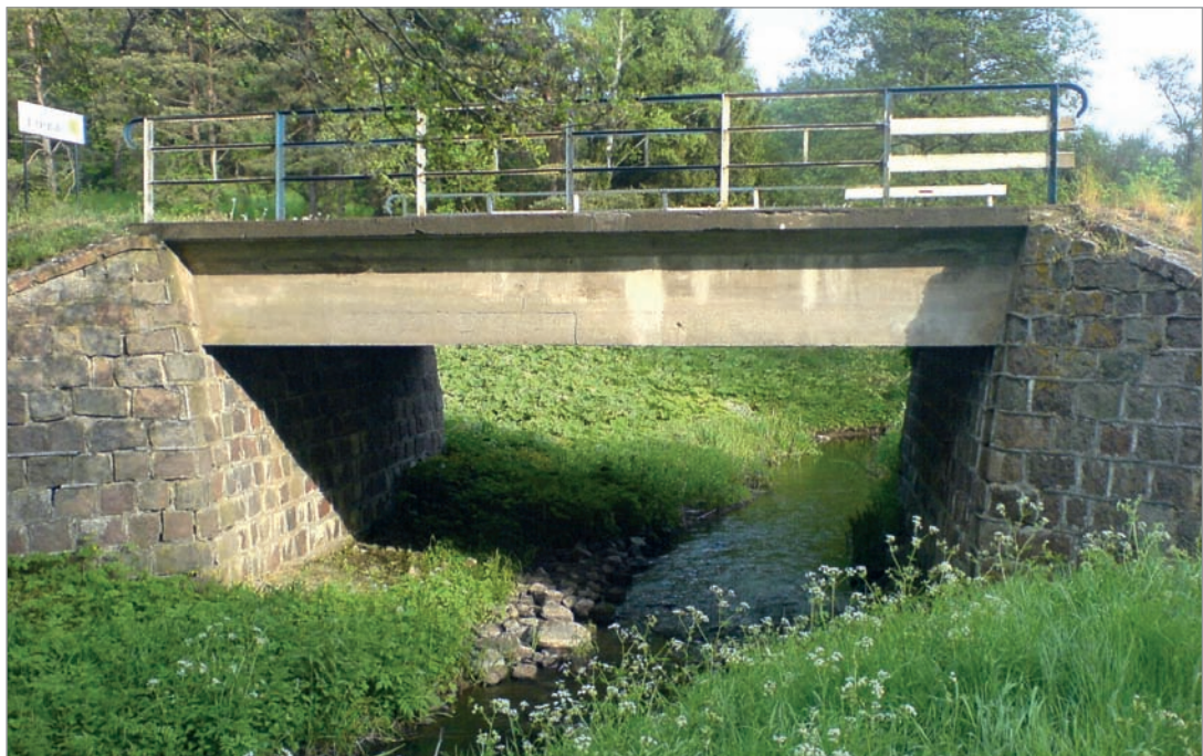
Fot. 54. Półka gruntowa pod małym mostem.
