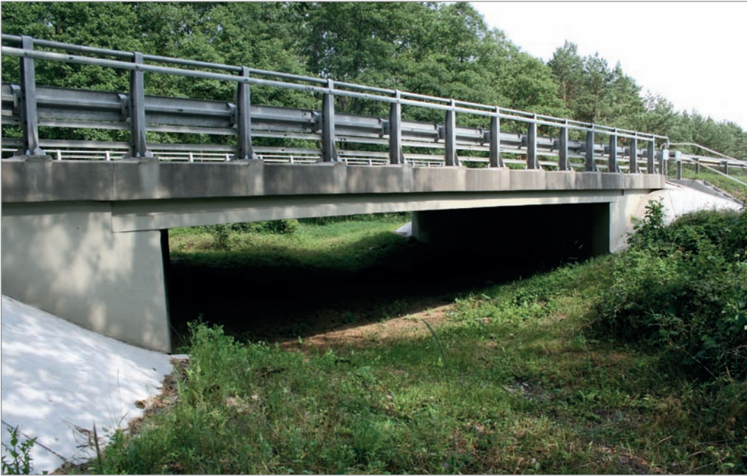
Fot. 51. Przejście dla małych zwierząt – most żelbetowy – droga krajowa nr 74.
