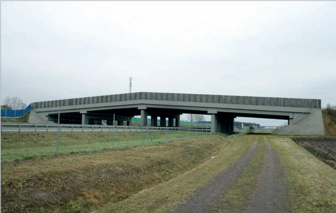
Fot. 112. Nieuzasadnione wydłużenie konstrukcji przejścia górnego ze względu na dodatkowe przęsła dla dróg serwisowych – autostrada A2.
