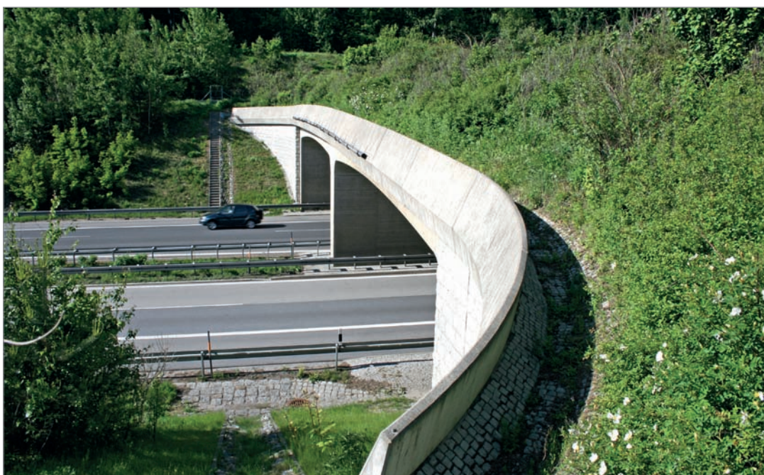
Fot. 140. Ekran betonowy na powierzchni przejścia górnego.
