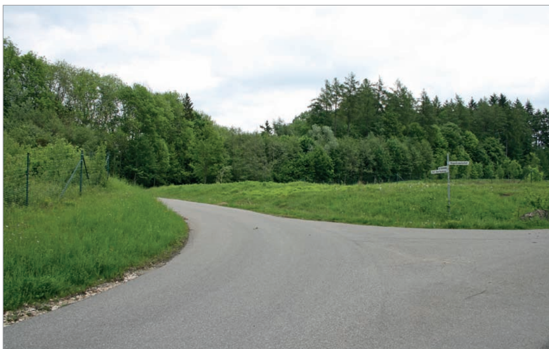
Fot. 91. Niedopuszczalne rozwiązanie – droga asfaltowa na powierzchni przejścia górnego – droga B31neu (Niemcy).
