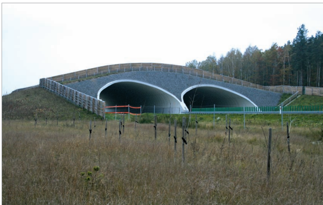
Fot. 75. Przykład przejścia o zbyt dużym kącie nachylenia najść – autostrada A4.
