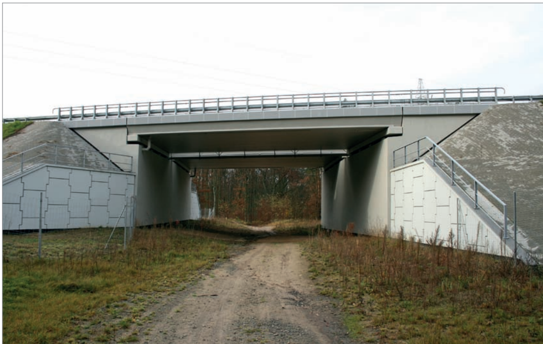
Fot. 41. Przejście dolne zespolone z drogą leśną – konstrukcja żelbetowa, jednoprzęsłowa – droga ekspresowa S-3.
