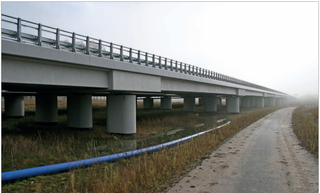
Fot. 108. Asfaltowa droga przecinająca strefę naprowadzania zwierząt do dużego przejścia dolnego – droga ekspresowa S-3.
