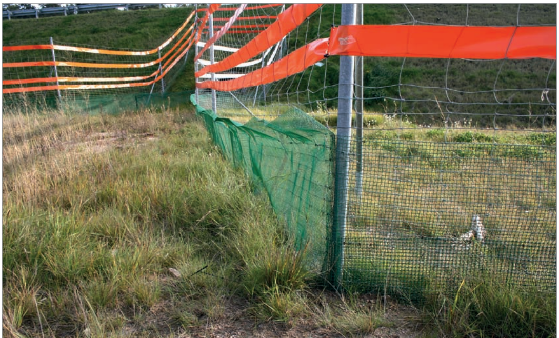
Fot. 104. Ogrodzenie wykonane za siatki polimerowej – materiał niezalecany ze względu na duże trudności z uzyskaniem szczelności oraz dużą podatność na uszkodzenia.
