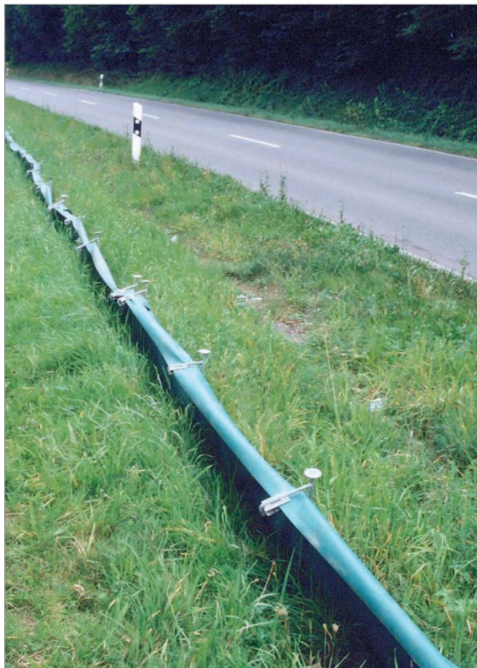
Fot. 129. Ogrodzenie tymczasowe z folii polimerowej.
