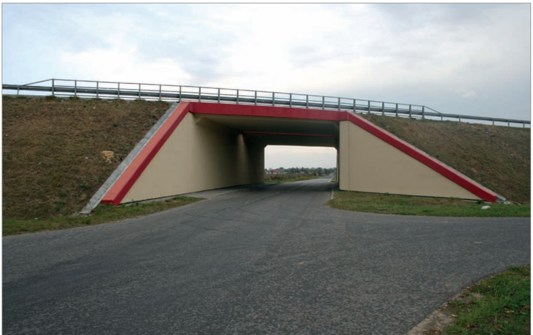
Fot. 6. Przykład obiektu, który nie powinien być projektowany jako przejście dolne zespolone – droga krajowa nr 17.
