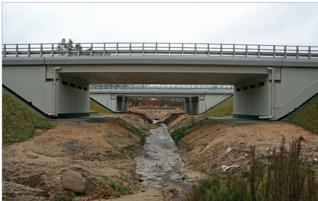
Fot. 71. Przejścia dolne zsynchronizowane – przejście pod drogą S-3 i równoległą DK3.
