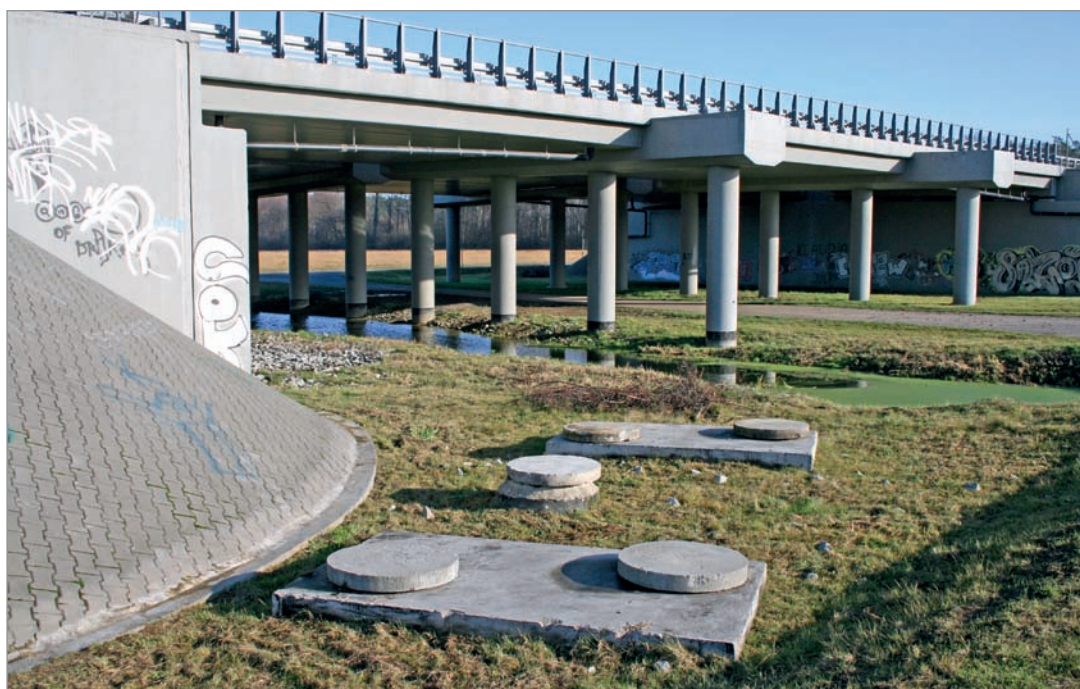
Fot. 117. Obiekty odwodnieniowe pozostające na powierzchni terenu wpływają odstraszająco na niektóre gatunki zwierząt.
