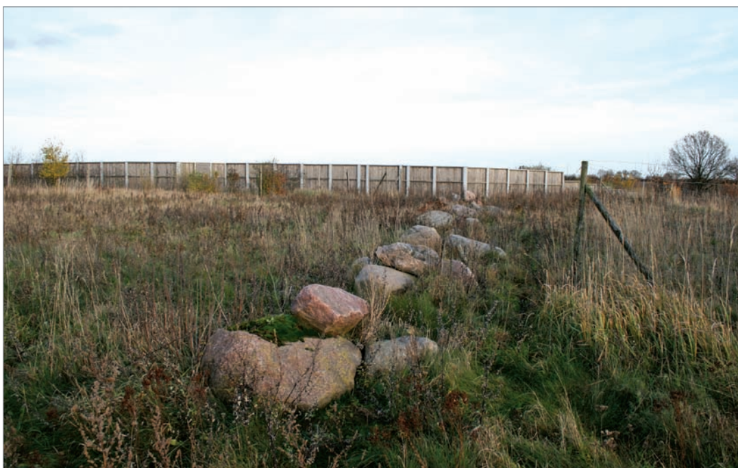
Fot. 32. Zabezpieczenia przed przejazdami w postaci głazów na powierzchni przejścia górnego – autostrada A20 (Niemcy).
