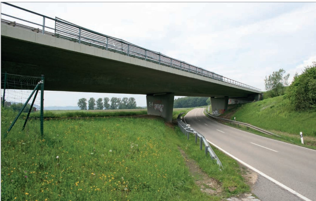
Fot. 92. Projektowanie przejść zespolonych pod wiaduktami dla ruchliwych dróg publicznych jest niewskazane.
