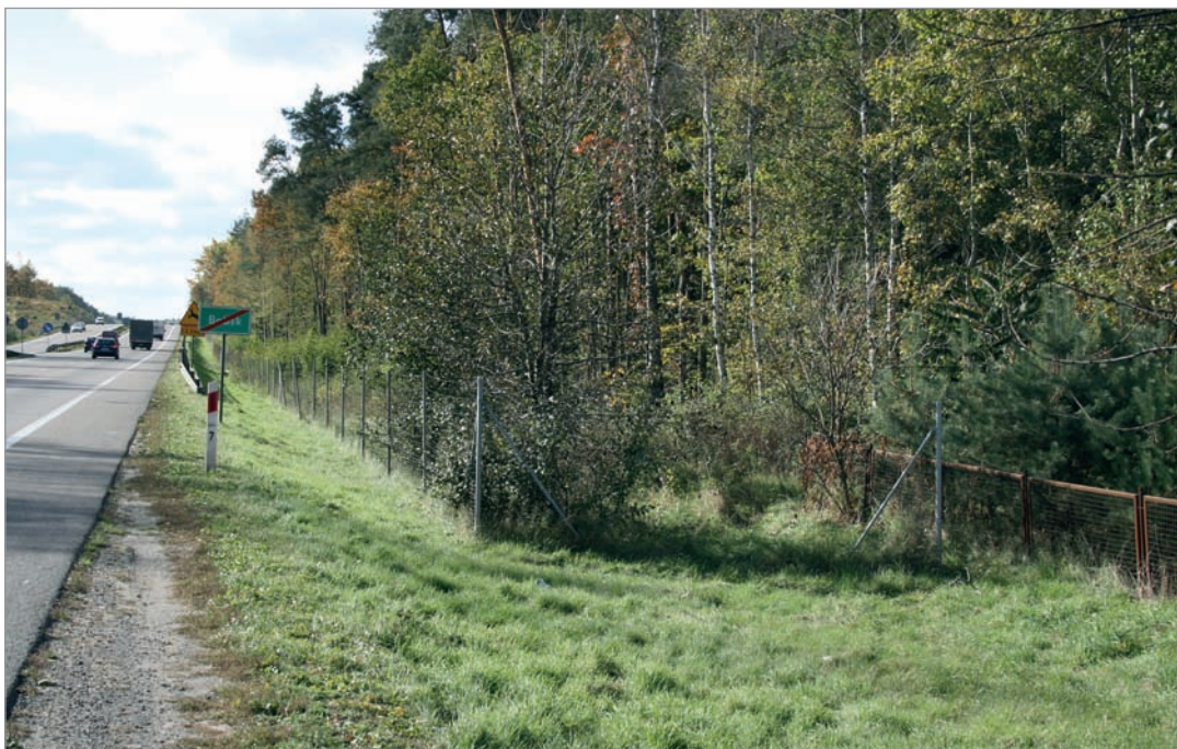
Fot. 122. Prawidłowe zakończenie ogrodzeń odcinkowych – płoty poprowadzone do terenów zabudowanych i połączone z ogrodzeniami posesji – droga krajowa nr 8.
