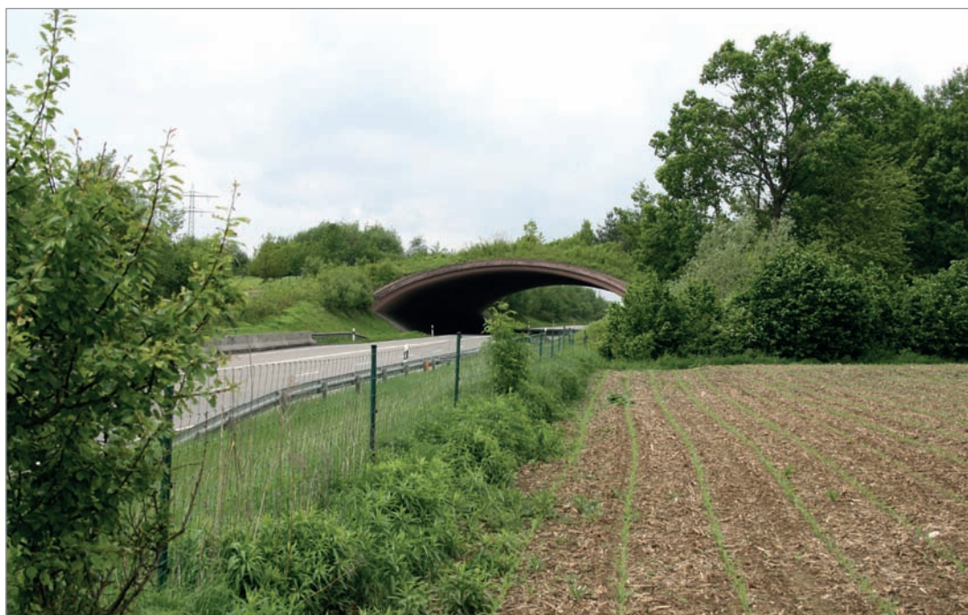
Fot. 7. Przejście górne duże – most krajobrazowy Weierholz – droga B31neu (Niemcy).
