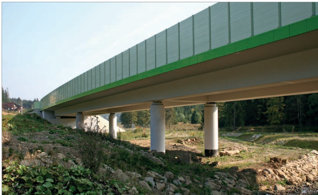
Fot. 141. Ekran panelowy na przejściu dolnym.
