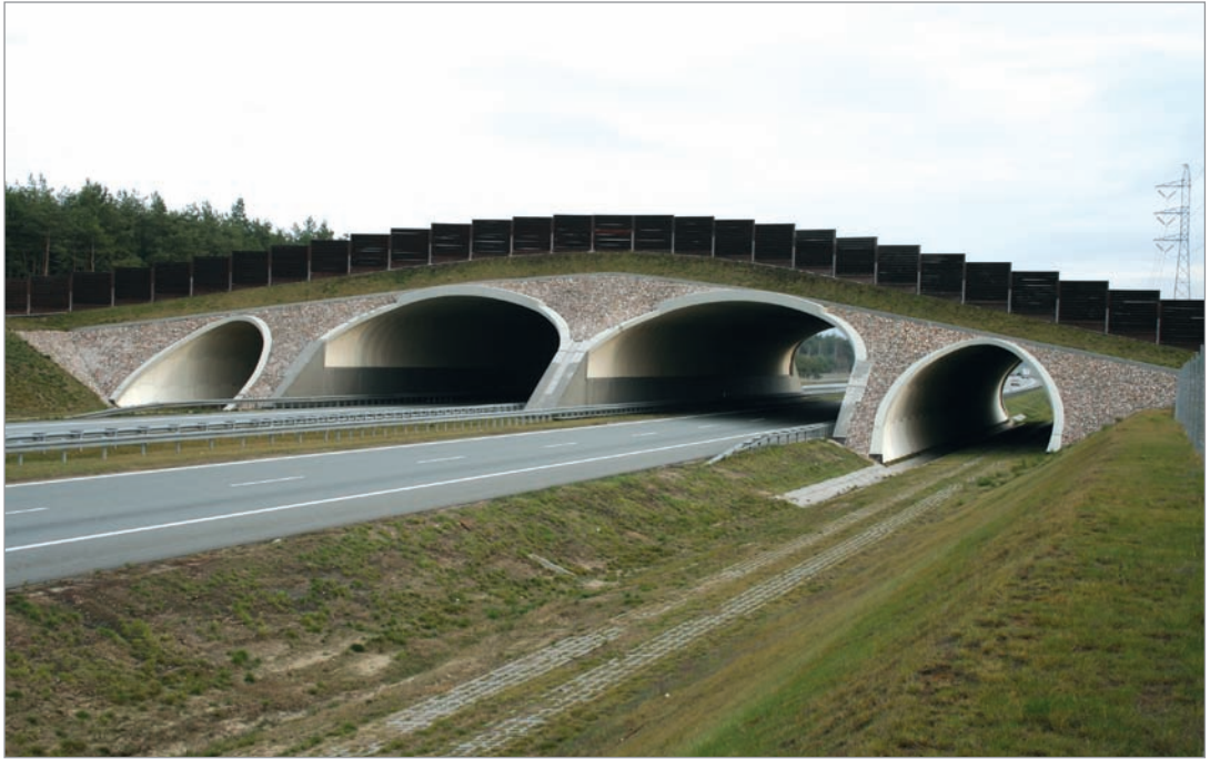
Fot. 28. Przejście górne dla dużych zwierząt przy autostradzie A2 – konstrukcja z blachy falistej.
