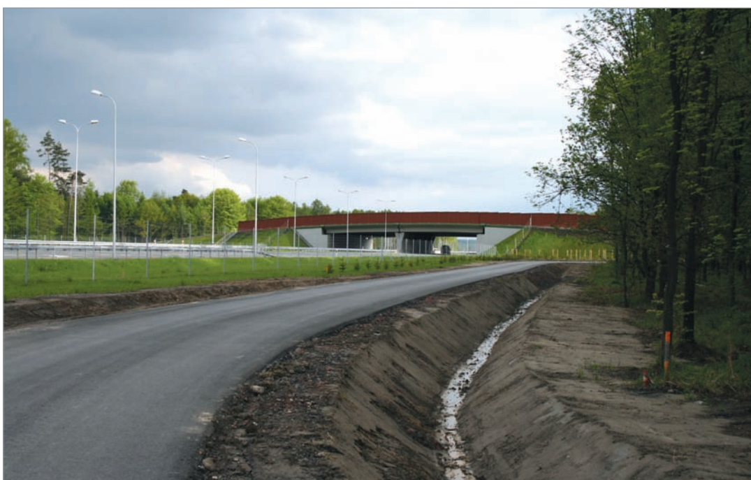
Fot. 4. Przejście dla dużych zwierząt zlokalizowane nad oświetlonym odcinkiem drogi (sąsiedztwo MOP) – autostrada A1.
