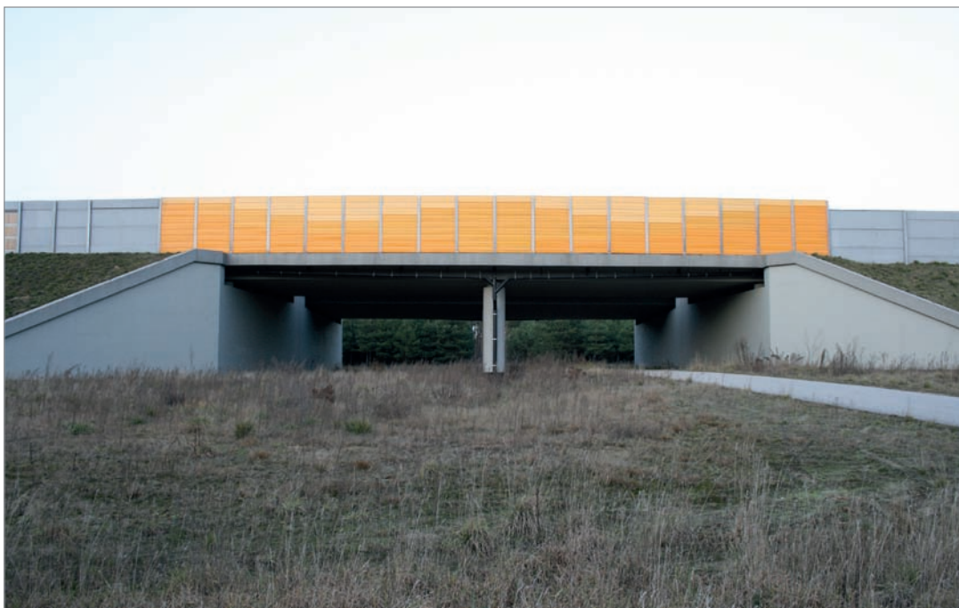
Fot. 42. Przejście dolne zespolone z drogą serwisową – konstrukcja żelbetowa, dwuprzęsłowa – autostrada A2.
