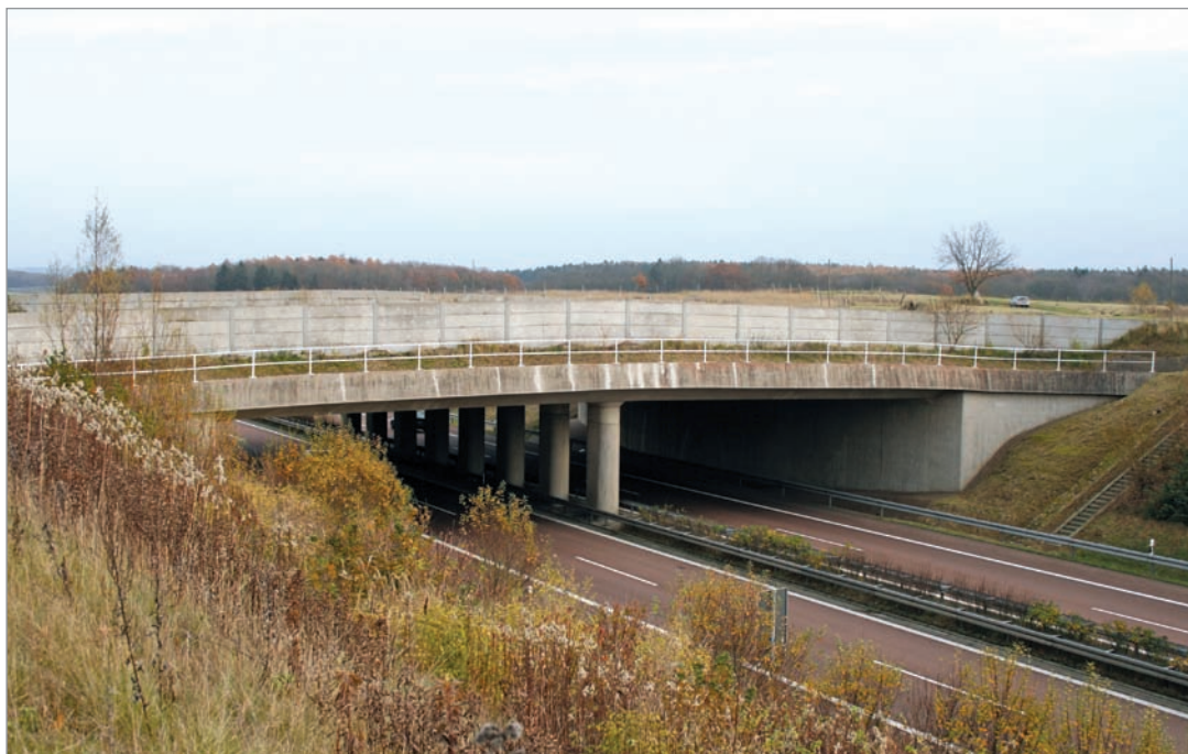
Fot. 17. Przejście dolne dla średnich zwierząt pod poszerzonym mostem dla strumienia – droga ekspresowa S-3.
