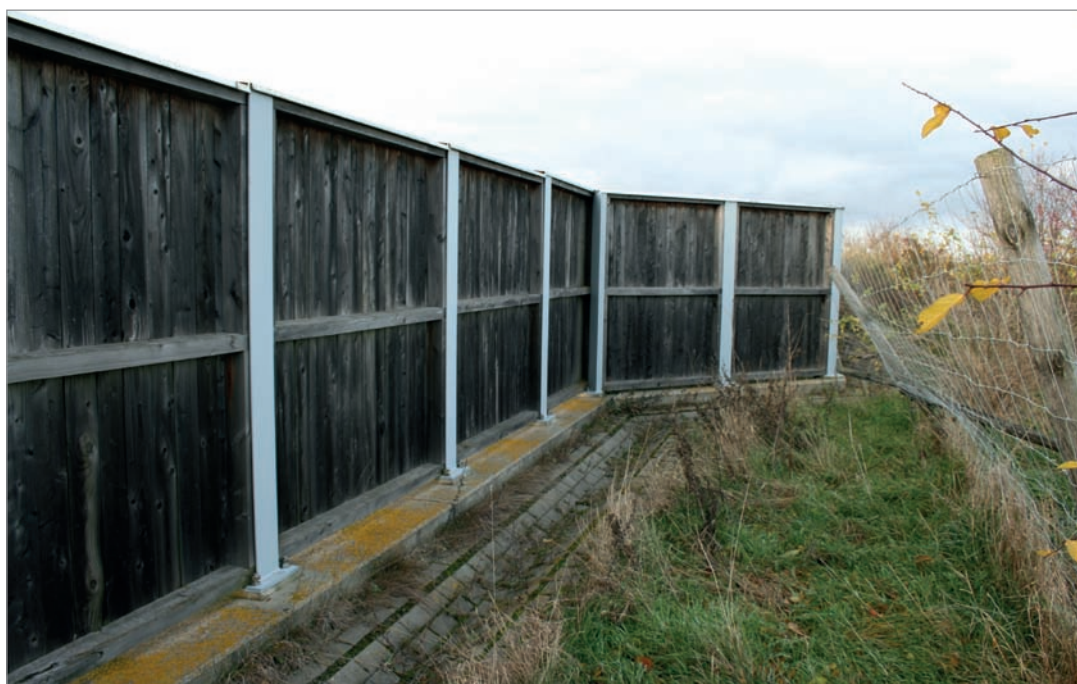
Fot. 136. Drewniany ekran odbijający na powierzchni przejścia górnego.
