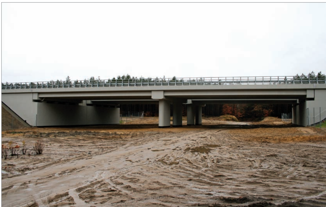
Fot. 18. Przejście górne dla średnich zwierząt zespolone z drogą gospodarczą – autostrada A20 (Niemcy).
