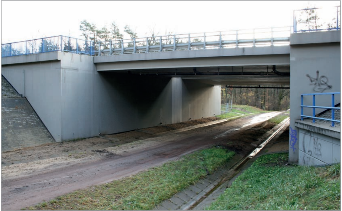
Fot. 93. Otwarte rowy, zwłaszcza umocnione elementami betonowymi, ograniczają efektywną szerokość przejść – autostrada A2.
