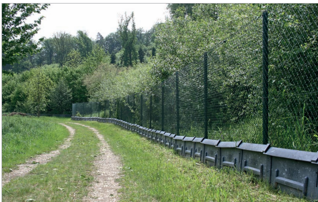
Fot. 121. Ogrodzenie wykonane z siatki stalowej plecionej powlekanej polimerami (dodatkowe ogrodzenie dla płazów z płyt polimerowych).
