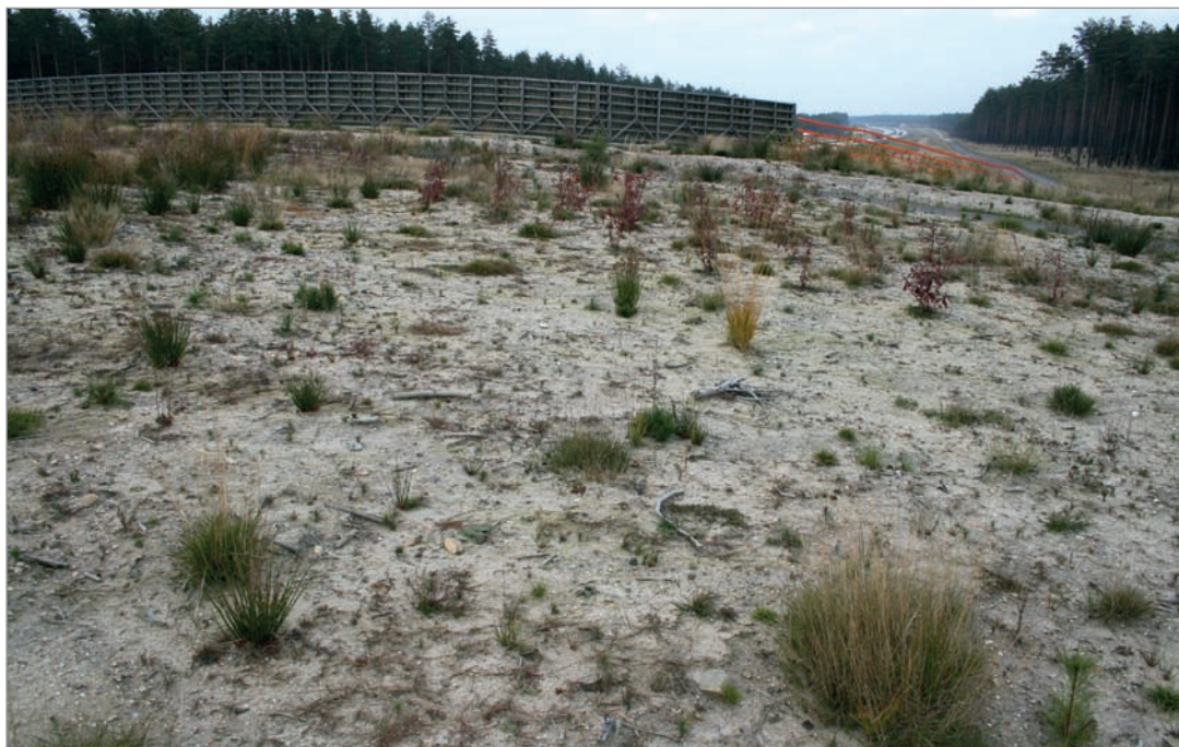
Fot. 87. Grunt niedostosowany do wymagań roślinności na powierzchni przejścia górnego – autostrada A4.
