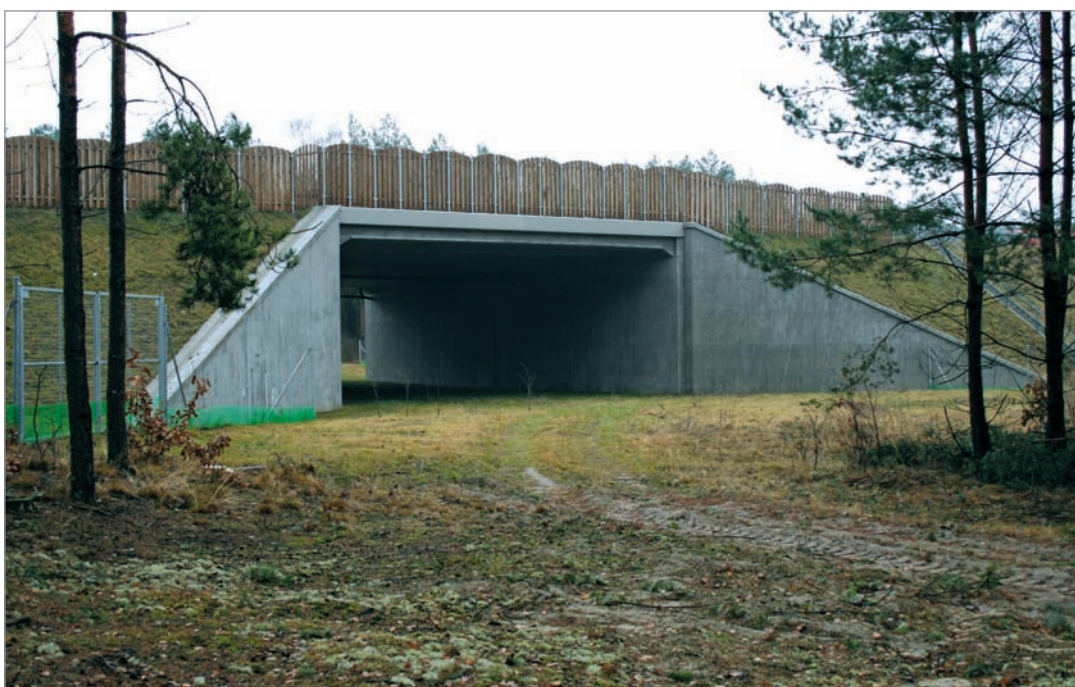
Fot. 13. Przejście dolne dla dużych zwierząt – autostrada A1.
