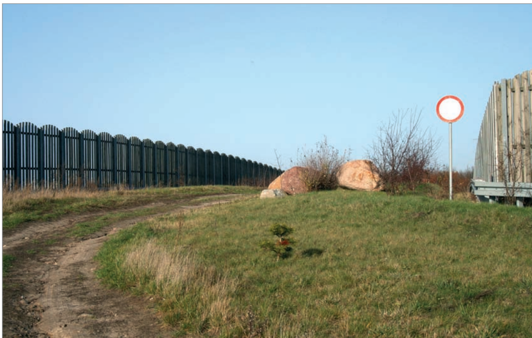
Fot. 33. Zabezpieczenia przed przejazdami w strefie przeznaczony dla zwierząt na przejściu górnych, wykonane z głazów – autostrada A2.
