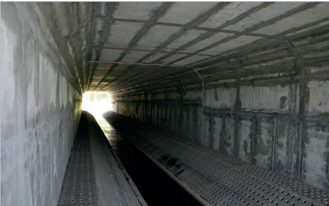
Fot. 96. Półki ziemne pokryte płytami betonowymi – autostrada A1.
