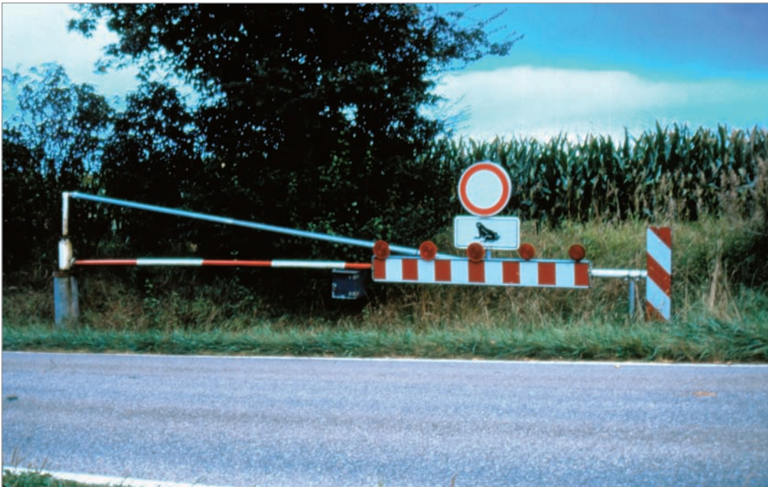
Fot. 135. Szlaban do okresowego zamykania drogi lokalnej w okresie migracji płazów – w południowych Niemczech.
