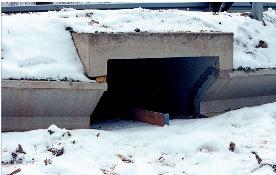
Fot. 60. Przepust żelbetowy z otwartym dnem – typowe rozwiązanie europejskie.
