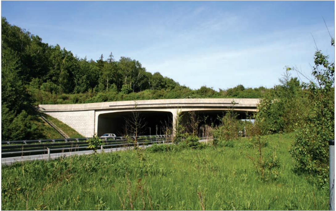
Fot. 11. Przejście górne dla dużych zwierząt – autostrada A4 (Niemcy).
