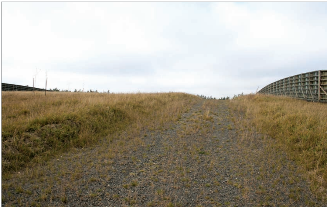
Fot. 35. Droga umocniona kruszywem na powierzchni przejścia górnego – autostrada A4.
