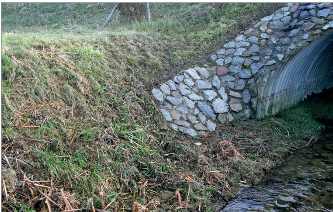
Fot. 55. Półka gruntowa w przepuście z blachy falistej.
