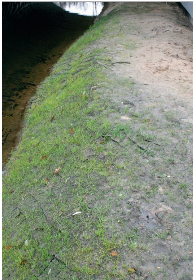
Fot. 157. W przypadku zagrożenia erozją boczną zaleca się stosowanie w umocnieniach koryt geosyntetyków szczelnie pokrytych gruntem.
