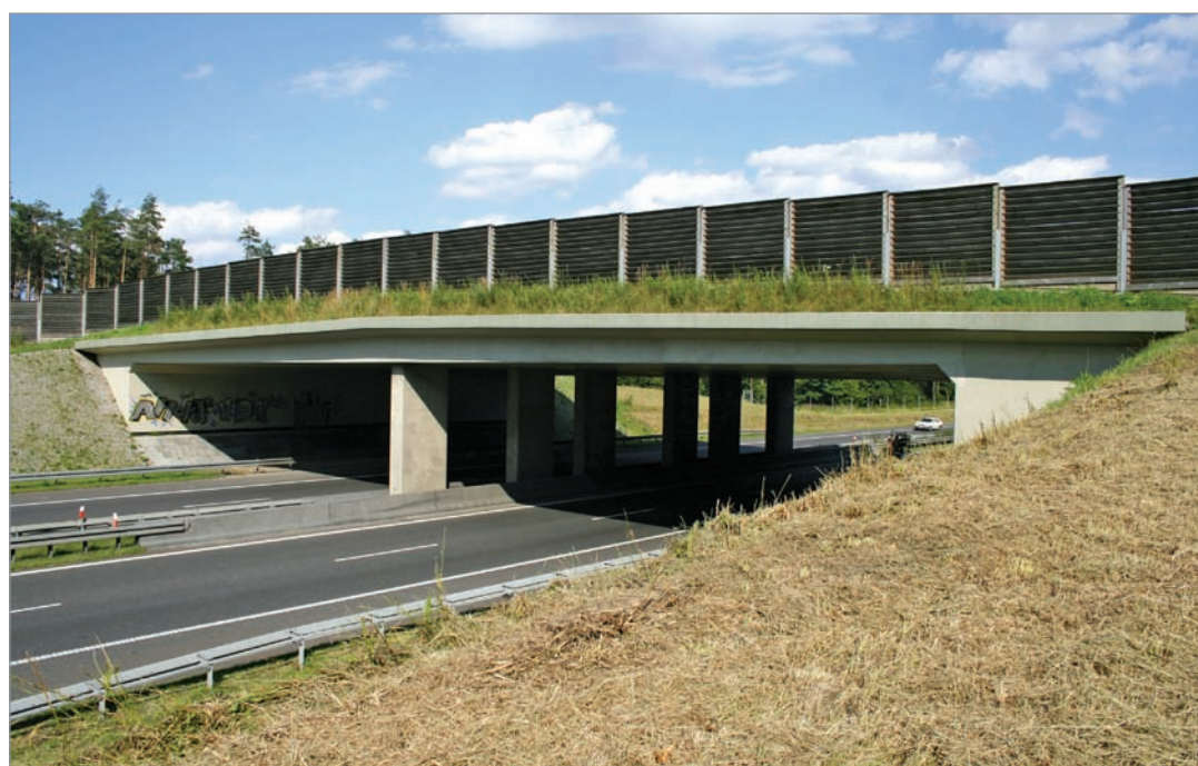
Fot. 27. Przejście górne dla dużych zwierząt przy autostradzie A4 – konstrukcja żelbetowa, płytowo-belkowa.
