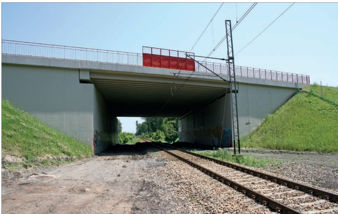
Fot. 46. Przejście dolne zespolone z linią kolejową – konstrukcja żelbetowa, jednoprzęsłowa – autostrada A1.
