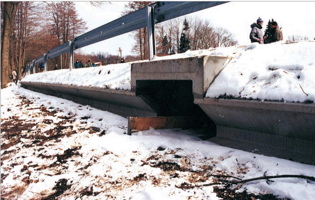
Fot. 16. Przejście dla płazów – droga powiatowa k. Kudowy.
