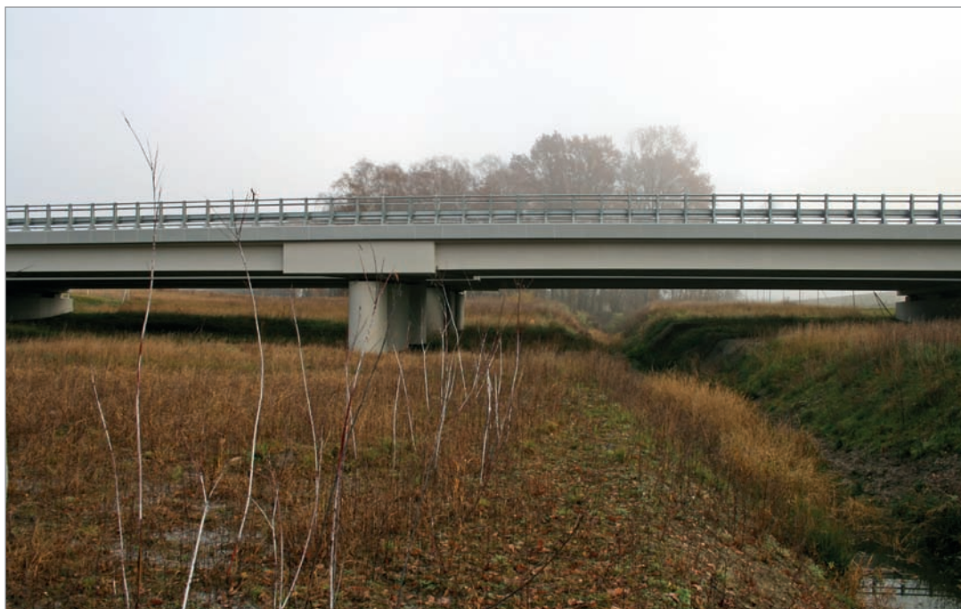
Fot. 45. Przejście dolne dla dużych zwierząt zespolone z potokiem – konstrukcja żelbetowa, dwuprzęsłowa – droga ekspresowa S-3.
