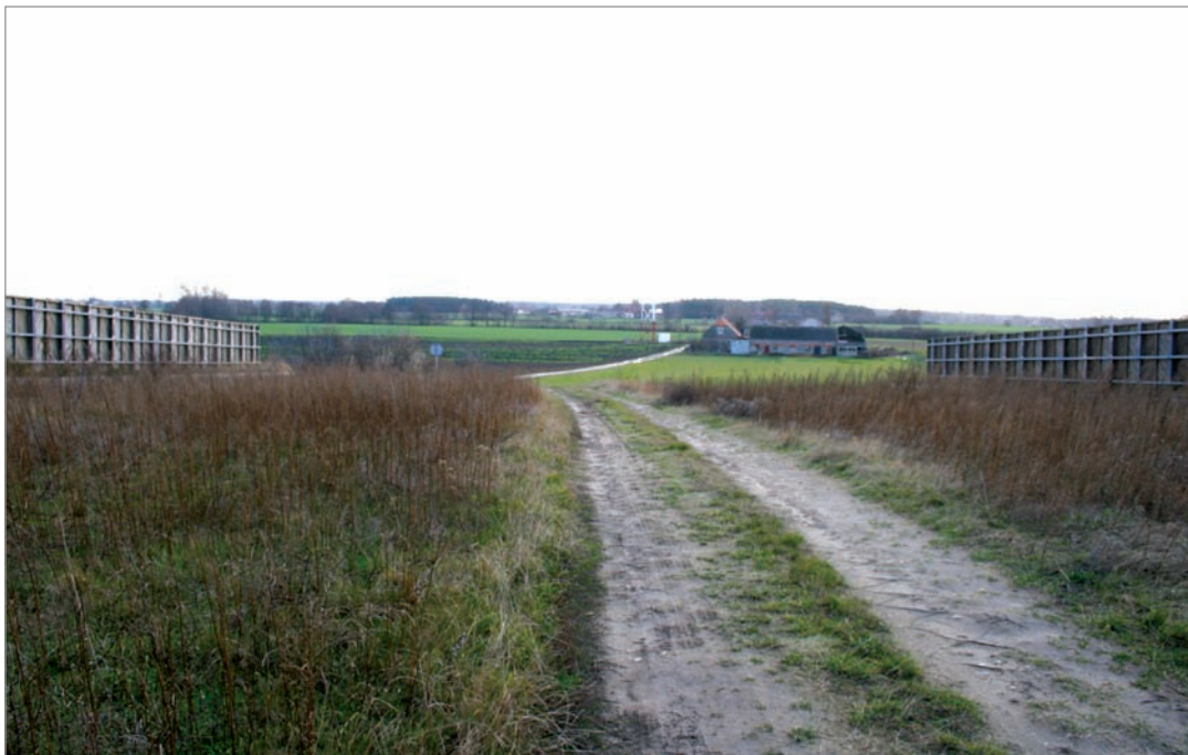
Fot. 3. Przejście o parametrach dla dużych ssaków leśnych zlokalizowane w obszarach polnych, dodatkowo lokalizacja przy niekorzystnym przebiegu niwelety drogi oraz w bezpośrednim sąsiedztwie terenów zabudowy – autostrada A2.
