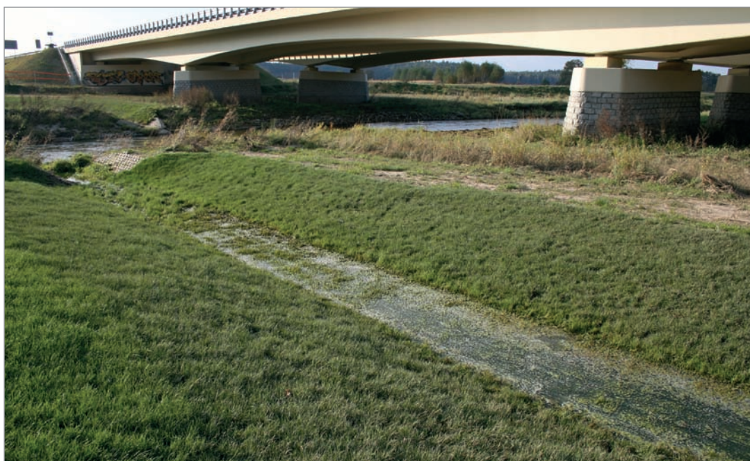
Fot. 65. Przykład rowu o wypłaszczonych skarpach w otoczeniu mostu krajobrazowego – autostrada A4.
