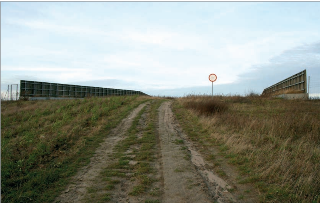
Fot. 89. Przykład nieskutecznych zabezpieczeń przed przejazdami z wykorzystaniem znaków drogowych – autostrada A2.
