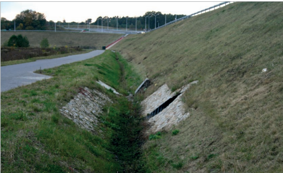
Fot. 106. Rów utrudniający dojdzie do małego przejścia dolnego.
