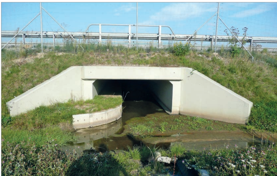
Fot. 56. Półka gruntowa z dodatkową ścianką zewnętrzną w przepuście żelbetowym.
