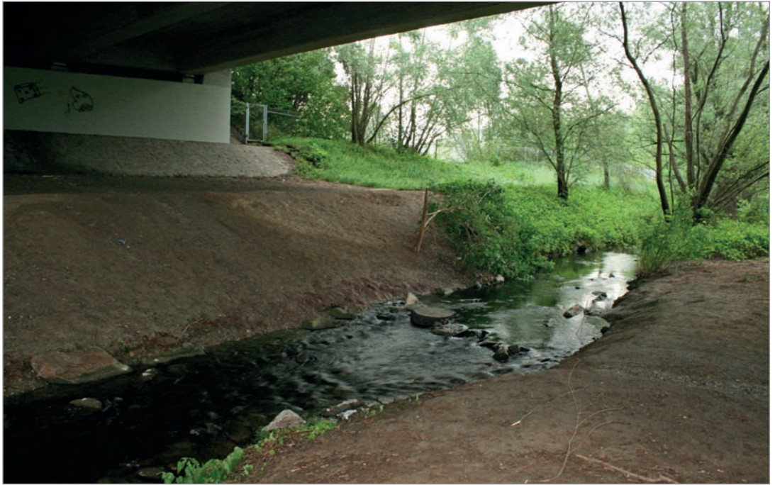
Fot. 156. W warunkach nizinnych zaleca się pozostawienie gruntowych skarp koryt cieków – bez dodatkowych umocnień.
