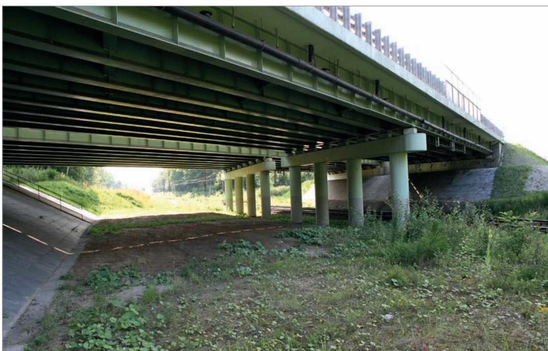
Fot. 47. Przejście dolne zespolone z linią kolejową – konstrukcja stalowa, wieloprzęsłowa – autostrada A4.
