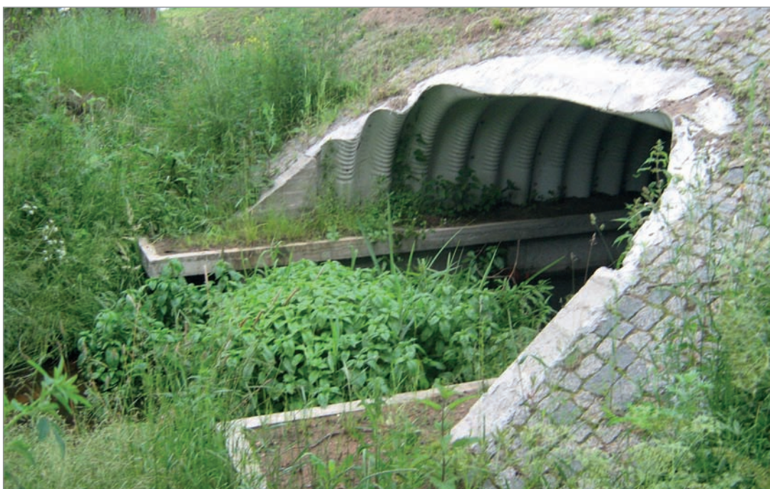
Fot. 61. Przepust z blachy falistej – otwarty profil na ławach żelbetowych – konstrukcja zalecana do wdrożenia w projektowaniu przejść dla płazów.
