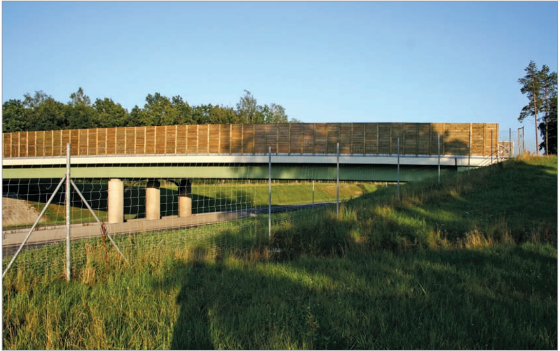
Fot. 37. Wąski wiadukt nad autostradą A4 (ok. 8 m. szer.) z lokalną drogą brukową – tego typu obiekty z ekranami mogą spełniać funkcje przejść dla nietoperzy (po wprowadzeniu nasadzeń naprowadzających).
