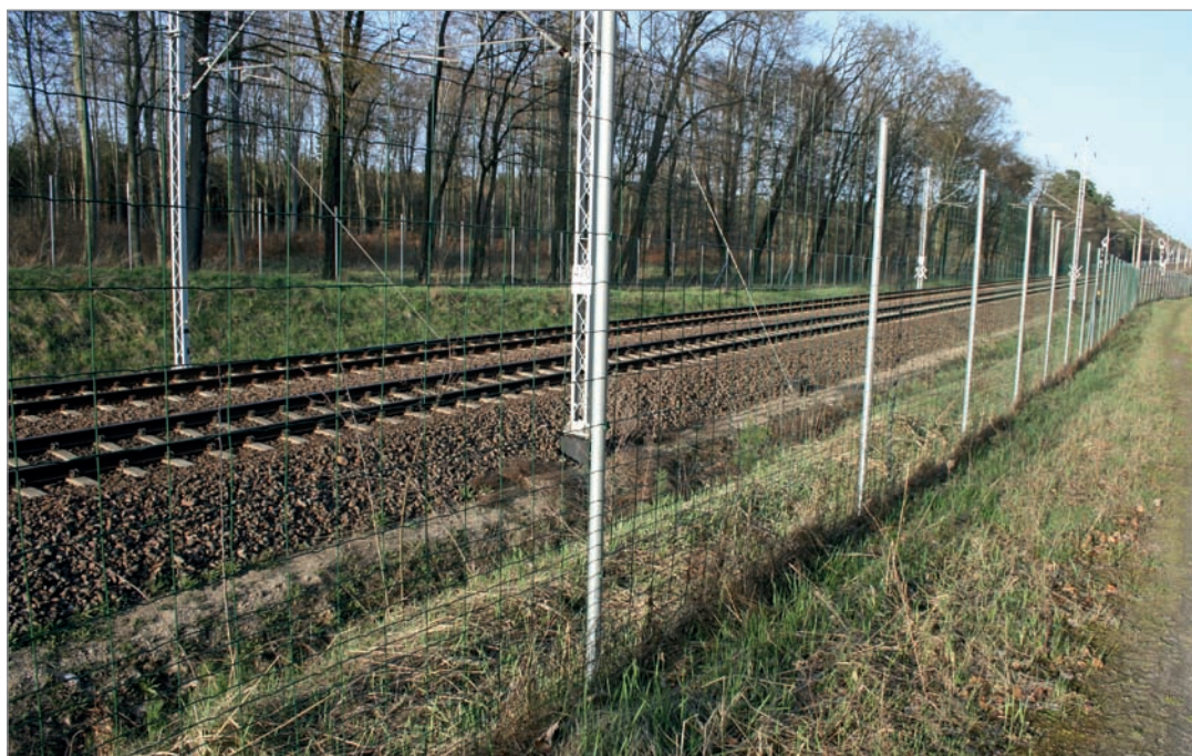
Fot. 159. Ogrodzenie ochronne dla dużych zwierząt wzdłuż linii kolejowej E2o w Puszczy Rzepińskiej.
