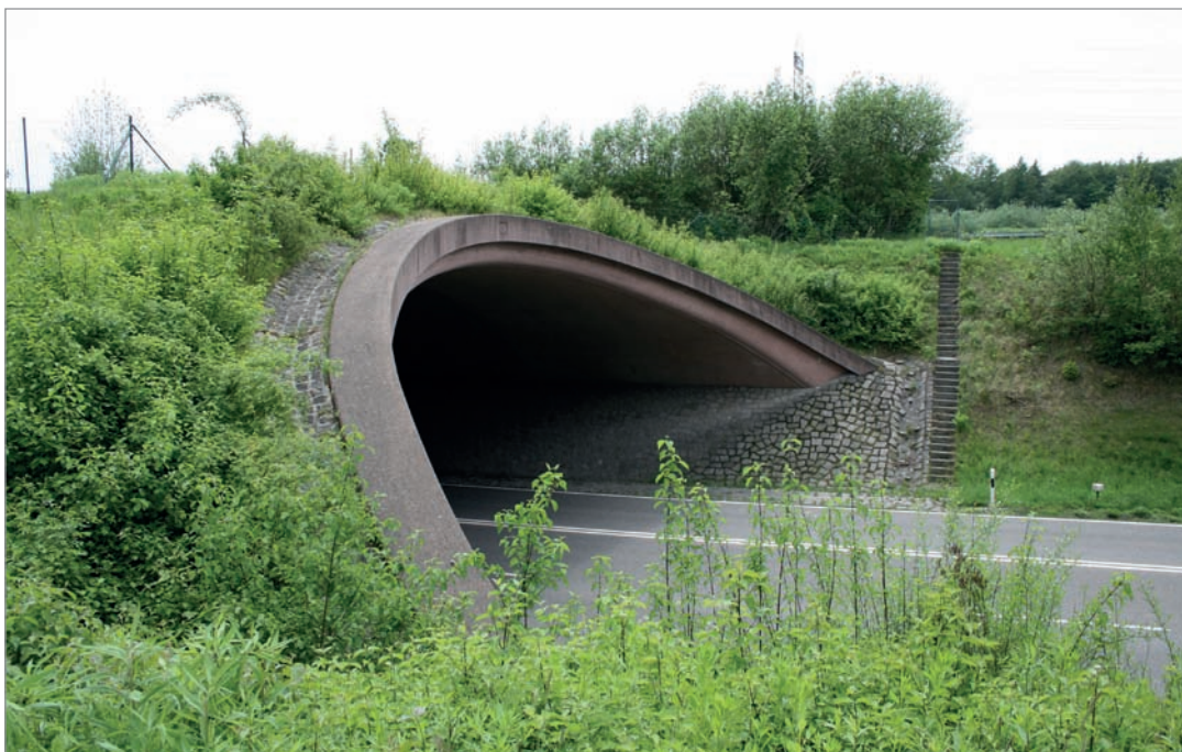
Fot. 143. Przebieg drogi w wykopie skutecznie izoluje powierzchnię przejścia od emisji hałasu.
