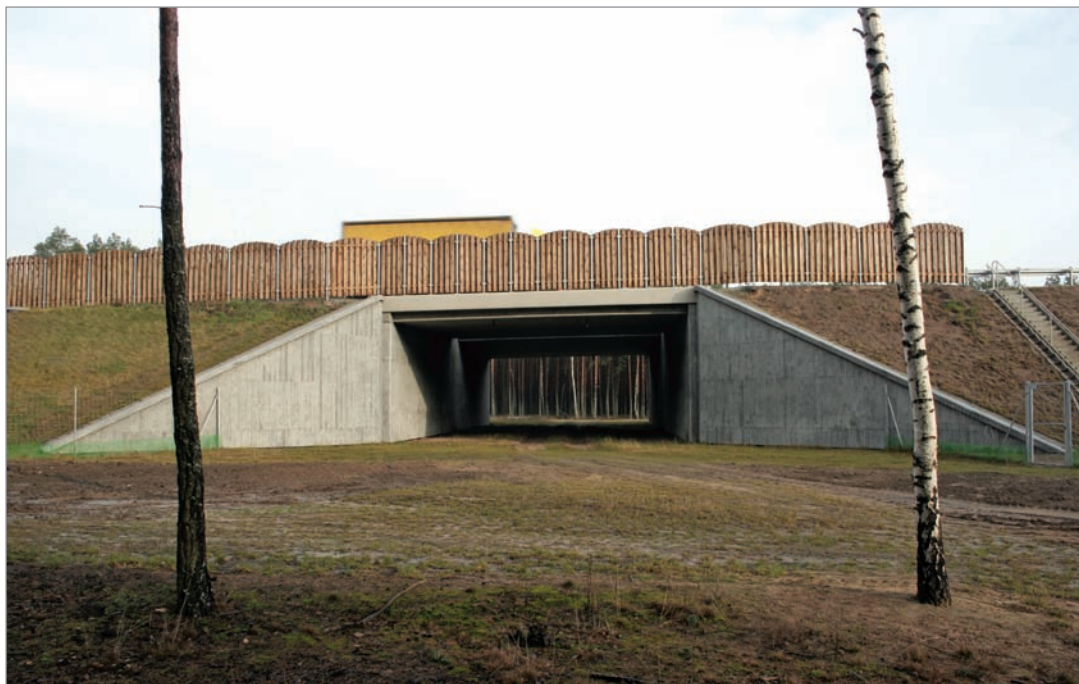
Fot. 38. Przejście dolne dla dużych zwierząt – konstrukcja żelbetowa, jednoprzęsłowa – autostrada A1.
