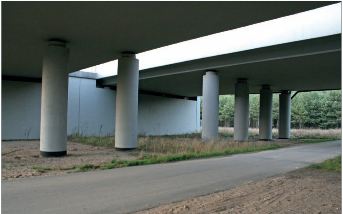
Fot. 78. Szczeliny i okna doświetleniowe bez ekranowania hałasu drogowego powodują ograniczenie skuteczności przejść – autostrada A2.
