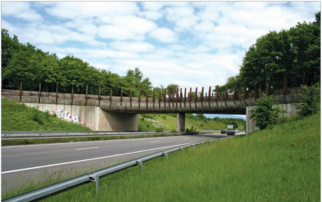
Fot. 12. Przejście górne dla średnich zwierząt – autostrada A36 (Francja).
