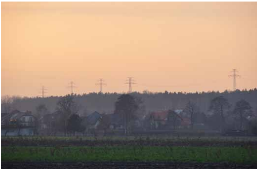
Ryc. 4.3. Okolice m. Janki koło Warszawy. Dwutorowa napowietrzna linia elektroenergetyczna o napięciu 110 kV na słupach nadleśnych.
